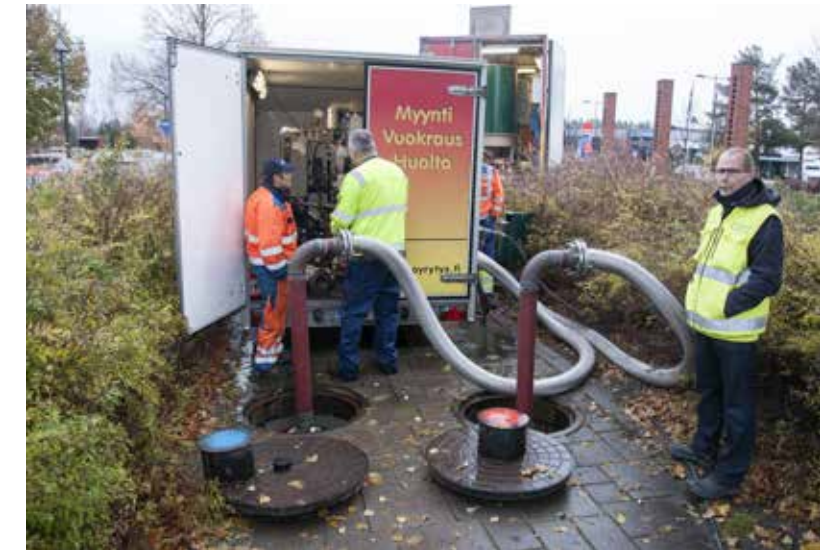
Varalämpöä verkostovaurion korjauksen aikana.
